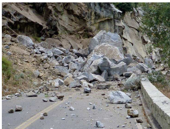
Fig. 01: effetti del crollo in roccia del 12 Giugno 2017 sulla El Portal Road
